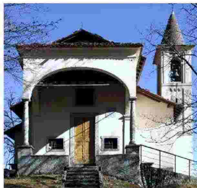
A Griante sorge la chiesa di San Martino, altro luogo di rilievo lungo il tracciato
